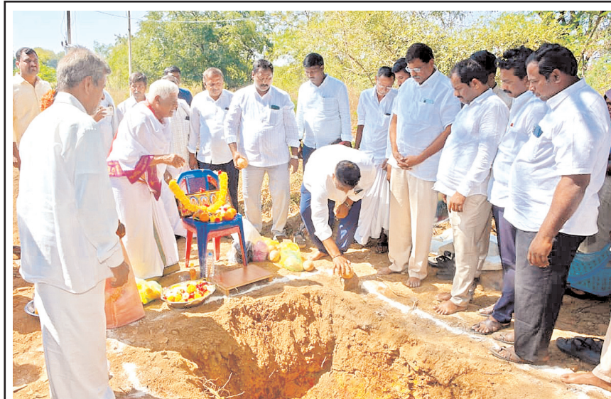
రాయచోటి, మనం న్యూస్, ఫిబ్రవరి 4, అన్నమయ్య జిల్లా, నిర్మించిన సిమెంటు రోడ్డును ప్రారంభించారు.
